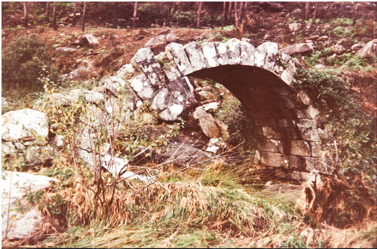
Ponte de San Xoán da Miserela - anos 80. Fotos: A. Parada.
